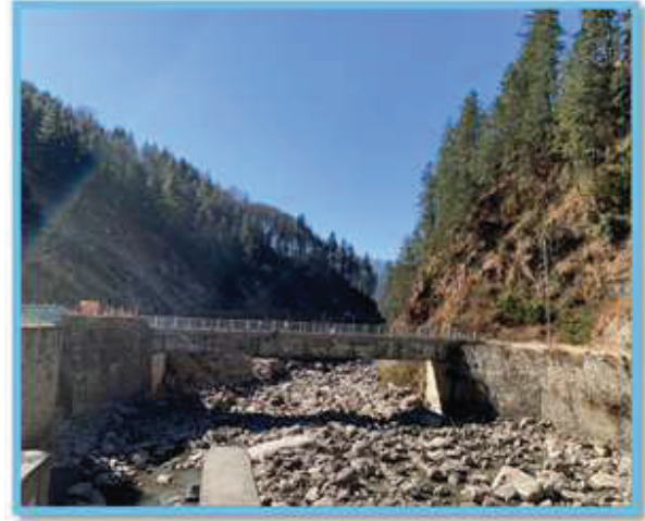
आयोजना र सोलु दुधकुण्ड नगपालिकाको सहकार्यमा निर्माण भएको पक्क मोटरेबल पुल
